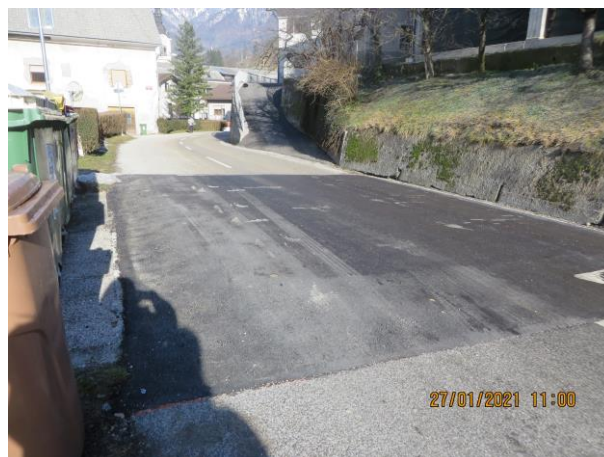
Slika št. 8: Gradnja naprave za umirjanje prometa v neskladju s tehnično specifikacijo za javne ceste TSC 02.203:2009
