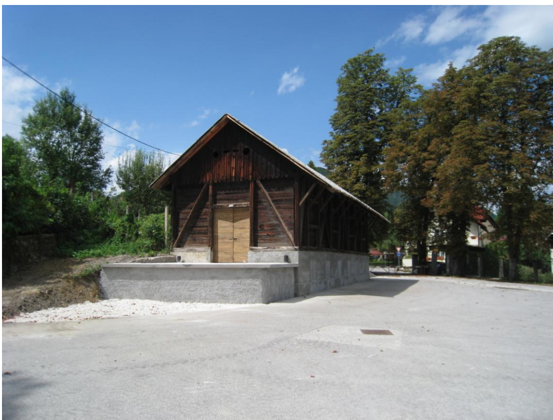
Pogled na leseno skladišče 10
