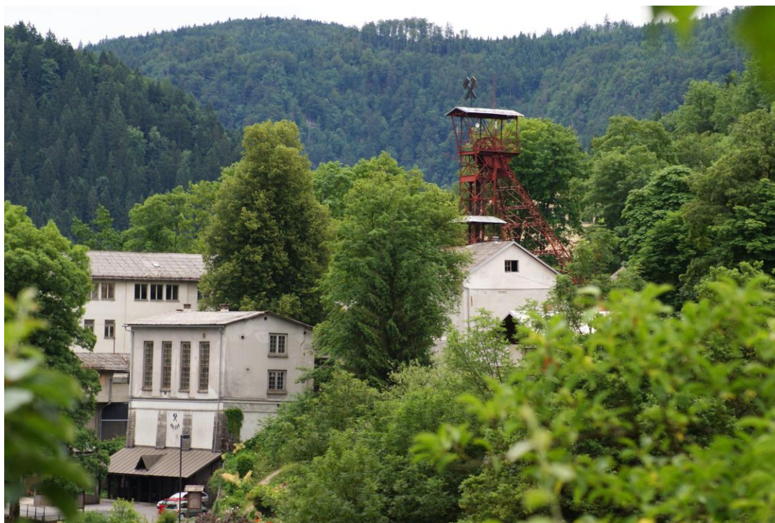
Pogled na kompleks iz Gregorčičeve ulice 7
