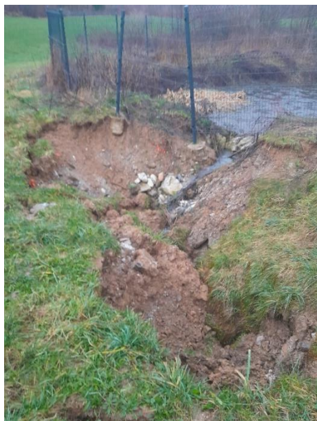
Slika 30: Udor ponikovalnega polja na ČN Godovič pred in po sanaciji
