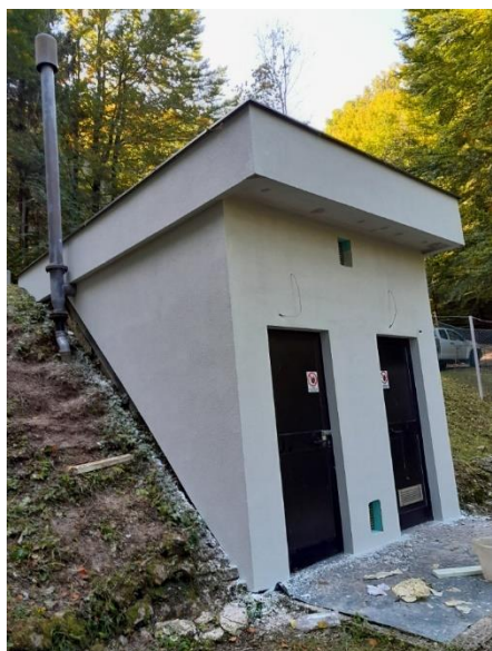
Slika 25: Obnovljen vodohran v Črnem Vrhu in razširjen vodohran na Vojskem
